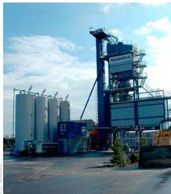
Wytwórnia Mas Mineralno-Asfaltowych, własność „SKANSKA”
